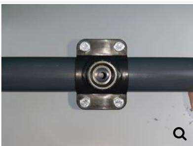
Bohren Sie ein Loch genau mittig mit einem Durchmesser von mindestens 10mm. Evtl. angesammelter Bohrstaub kann später mit einem Staubsauger abgesaugt werden.
